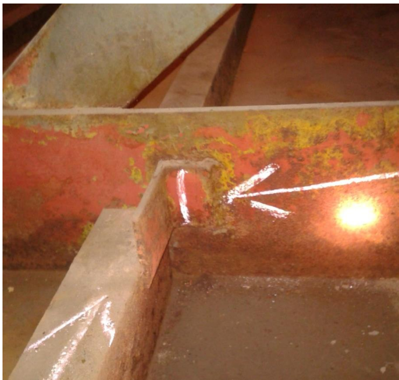
Рис. 1. Кріплення вузла жорсткості до діафрагми
