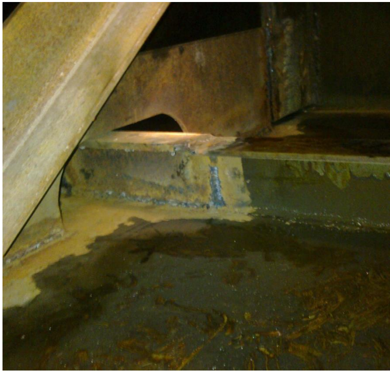
Рис. 3. Рекомендована конструкція зварного вузла
